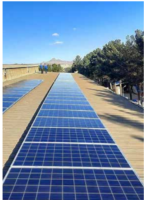
• طراحی و اجرای نیروگاه خورشیدی ۱۰۰ کیلووات کارخانه پارس‌تابلو
